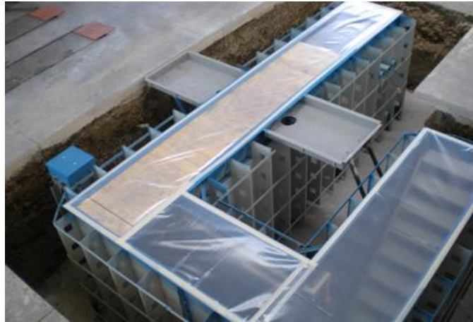
Figura – fossa prefabbricata per revisioni
